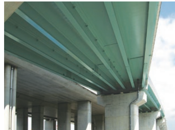
横桁や対傾構がないため、維持管理 (目視点検) が容易です。
