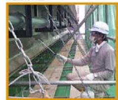
三次散水(兼残材清掃)
