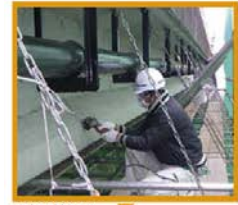
防水下地処理
