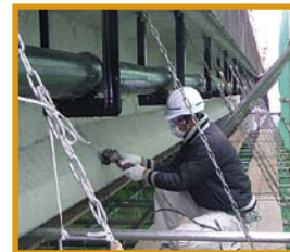
防水下地処理
