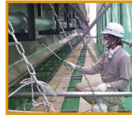
三次散水(兼残材清掃)
